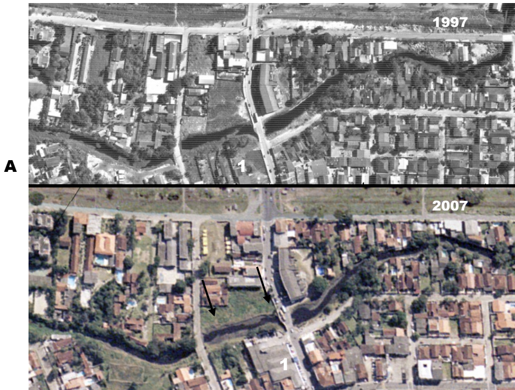
Figura 02: Fotografias aéreas de 1997 e 2007 do Rio do Poço, próximo à Rua dos Fundadores.
