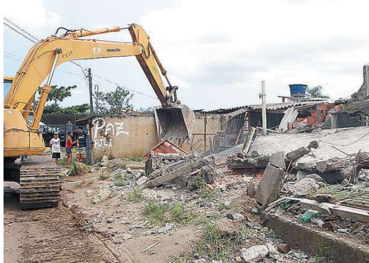
Com máquinas, mais de 100 habitações foram reduzidas a escombros
