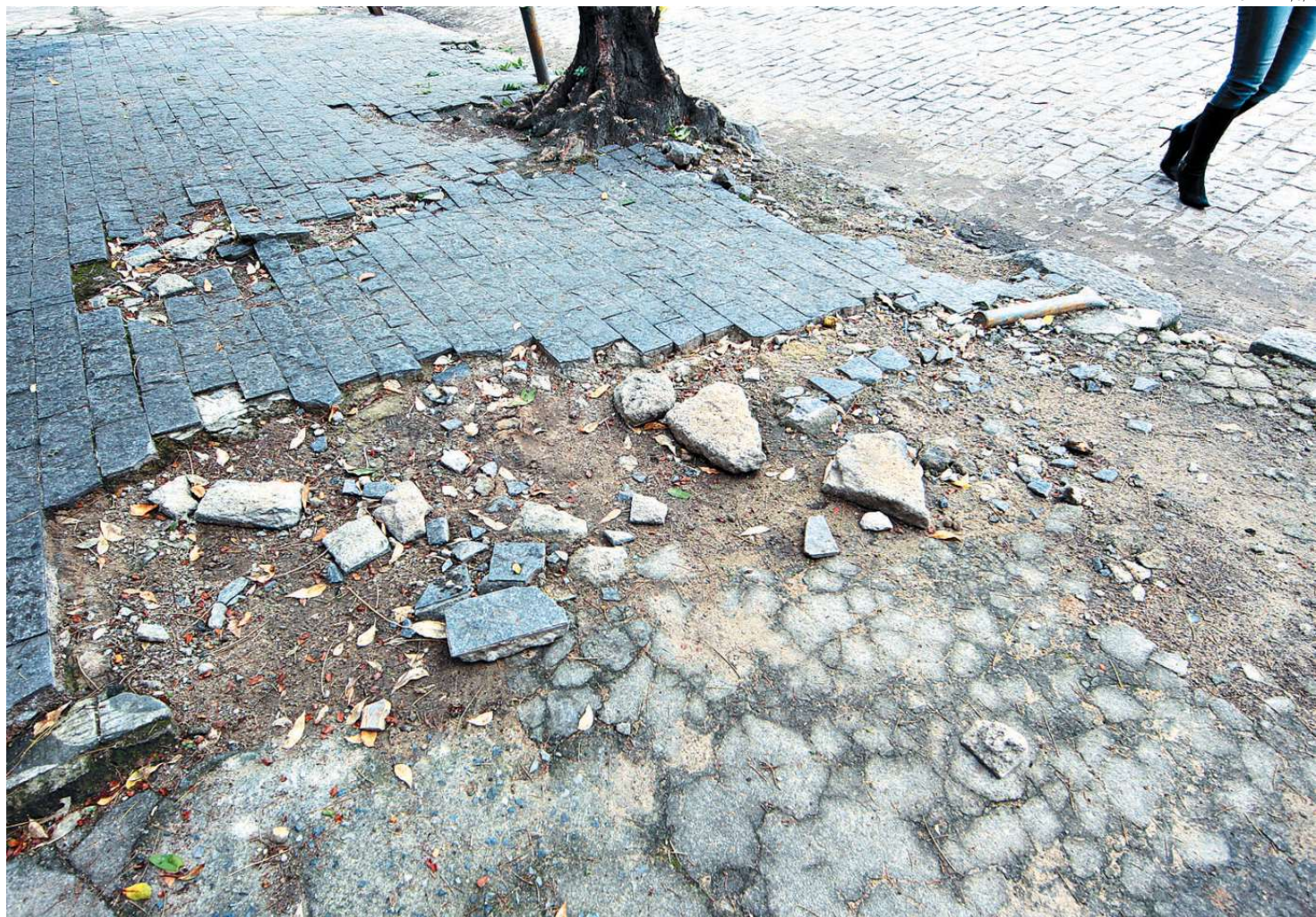
Calçadas esburacadas, sem o pavimento adequado e com obstáculos, estão entre as principais queixas recebidas pela Ouvidoria do Município
