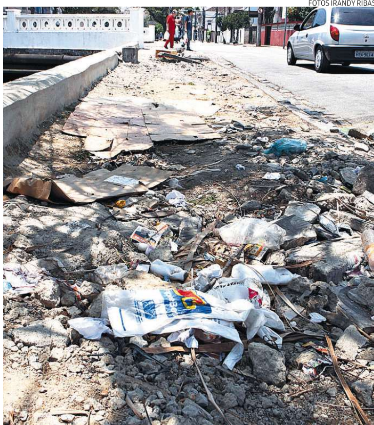
Para arrumar o piso, todo o calçamento foi destruído e será refeito
