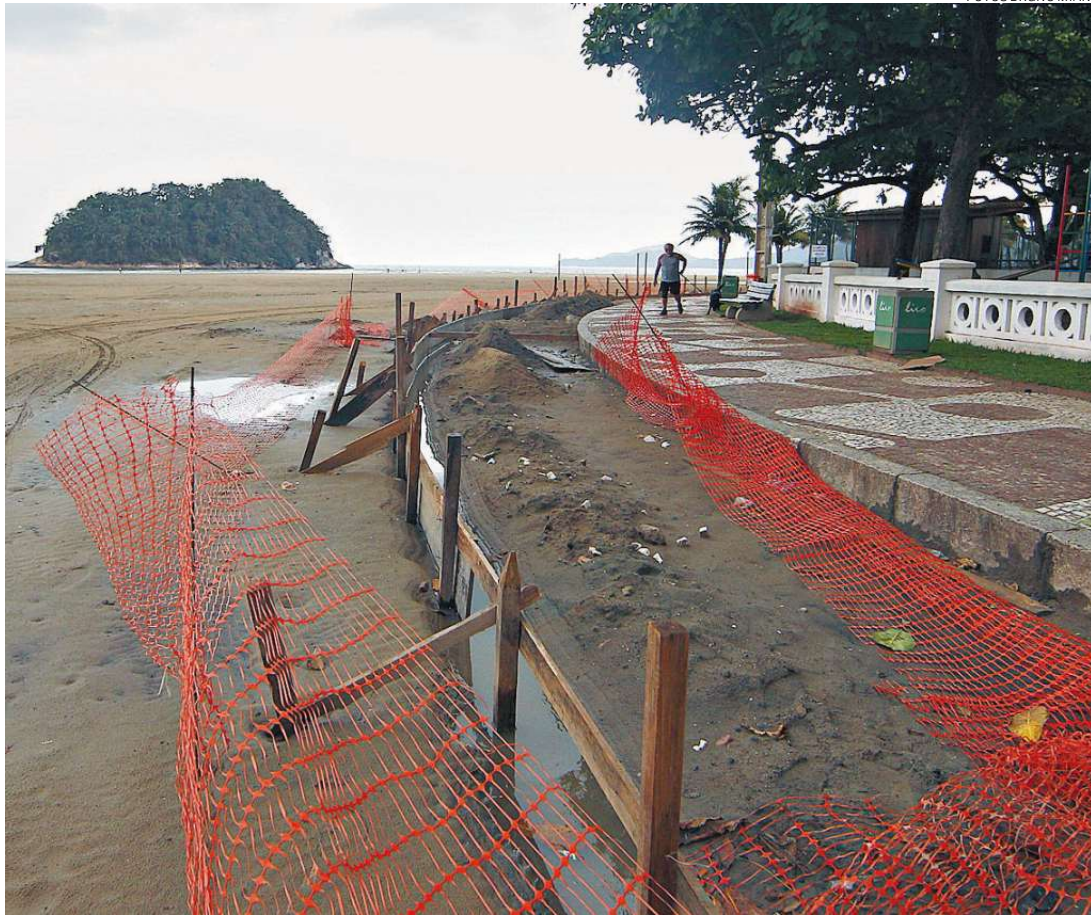
Parte da ciclovia ficará perto da faixa de areia da Praia do José Menino. Obra já ultrapassou a metade
