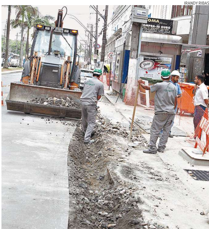
Obras transcorrem entre as praças das Bandeiras e Independência
