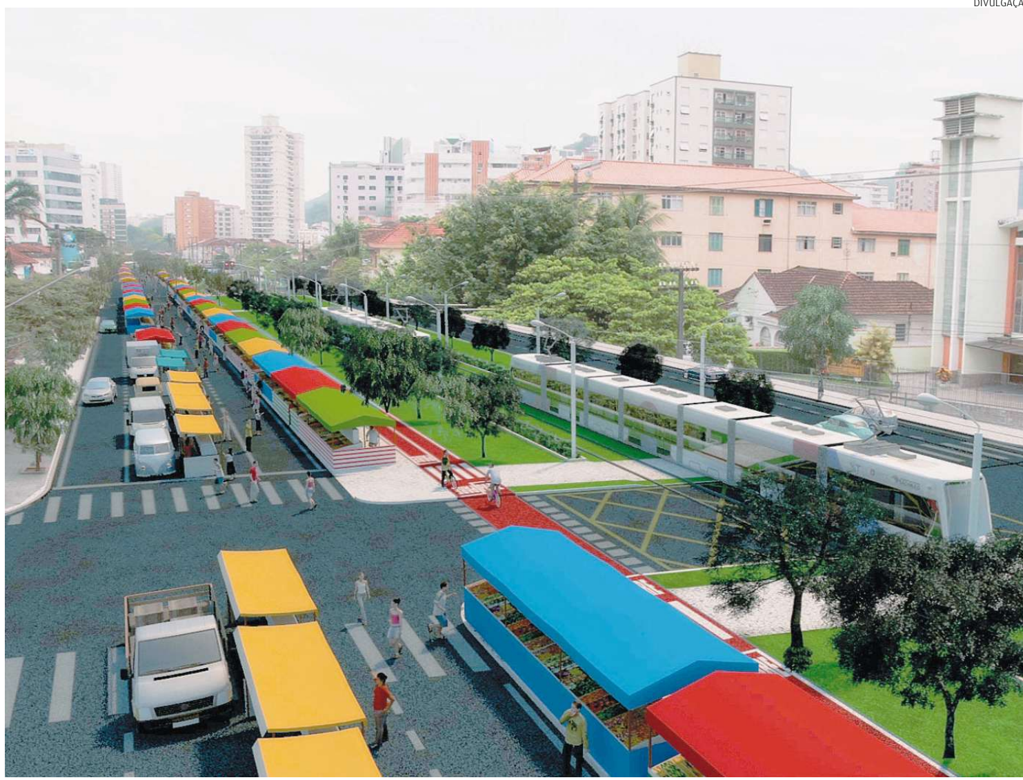
Após as obras para a implantação do VLT, a via ficará mais larga, com quatro faixas em cada lado. As bancas serão montadas em três faixas
