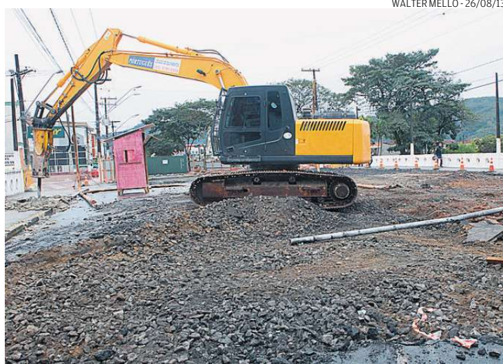
Em São Vicente, modal passará por viaduto da Av. Antonio Emmerich
