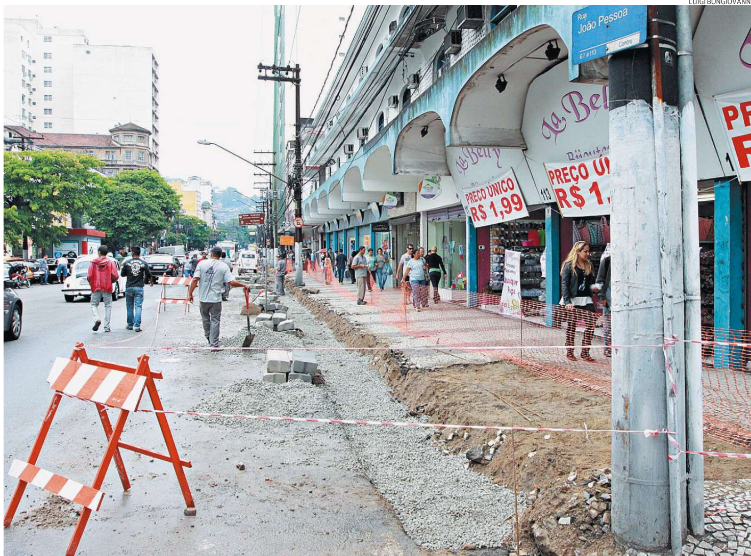
Uma das etapas do projeto é a troca do piso das calçadas da via por concreto desempenado (liso), além de intervenções em guias e sarjetas
