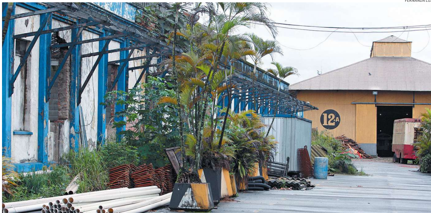
A recuperação do Armazém de Bagagens da Estação do Valongo (construção à esquerda) não deve ser concluída antes da Copa do Mundo
