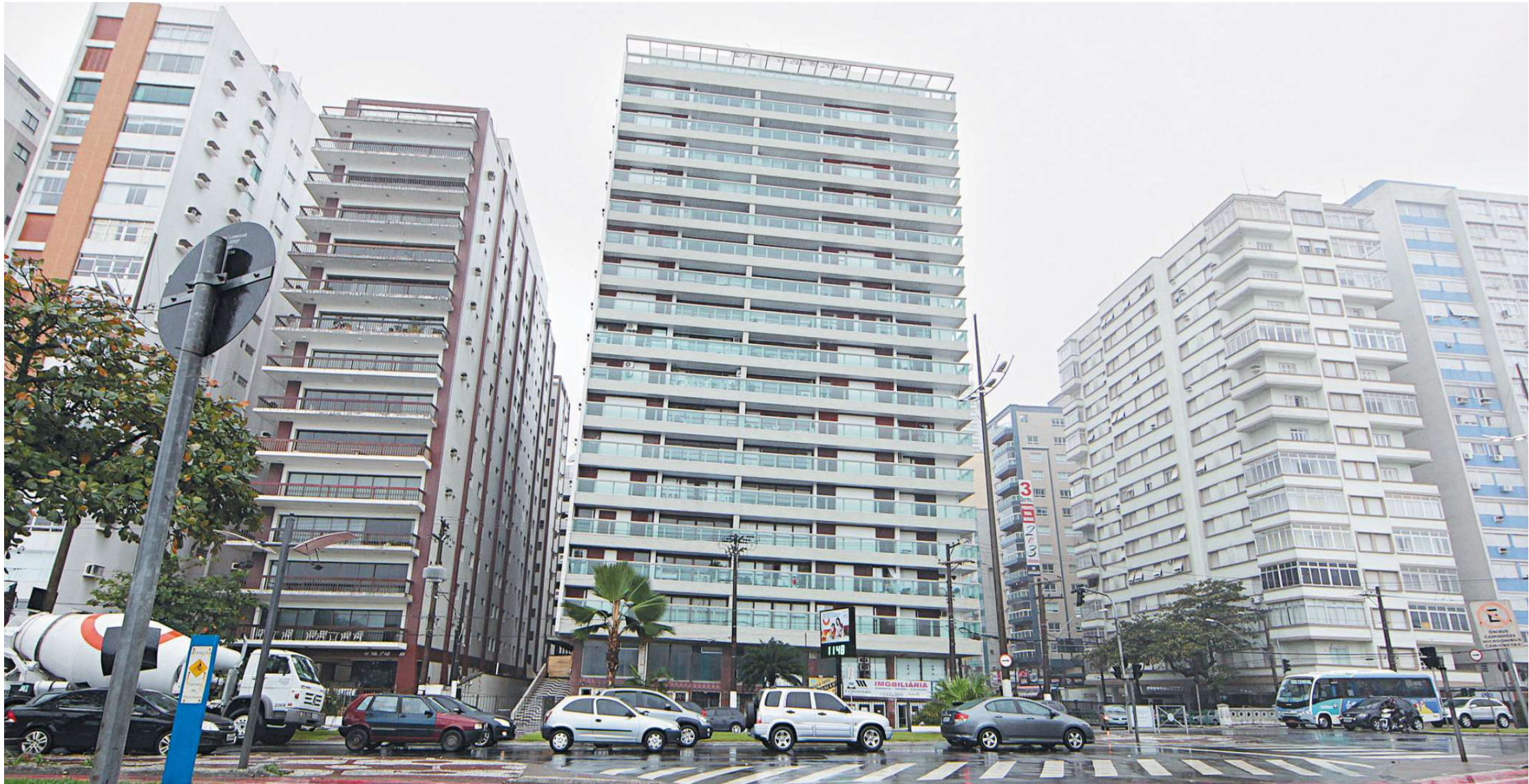
As edificações que estão na mira da Prefeitura de Santos se destacam pela imagem inusitada vista da areia e, agora, devem ser alvo de um estudo sobre possível risco estrutural decorrente da inclinação
