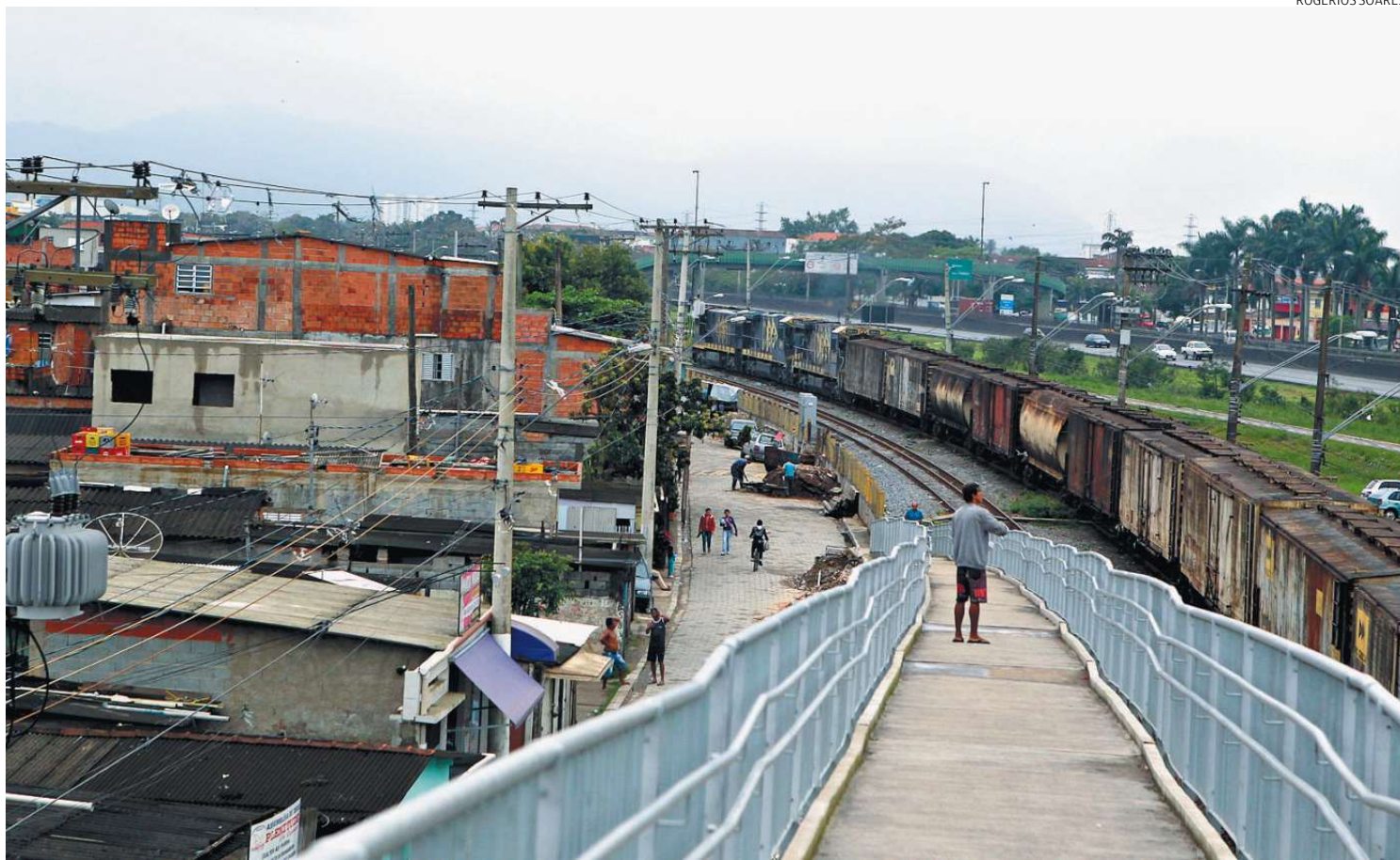
O lote onde está a Vila dos Pescadores fica encravado entre a Rodovia Anchieta e o Rio Casqueiro e começou a ser ocupado há 50 anos
