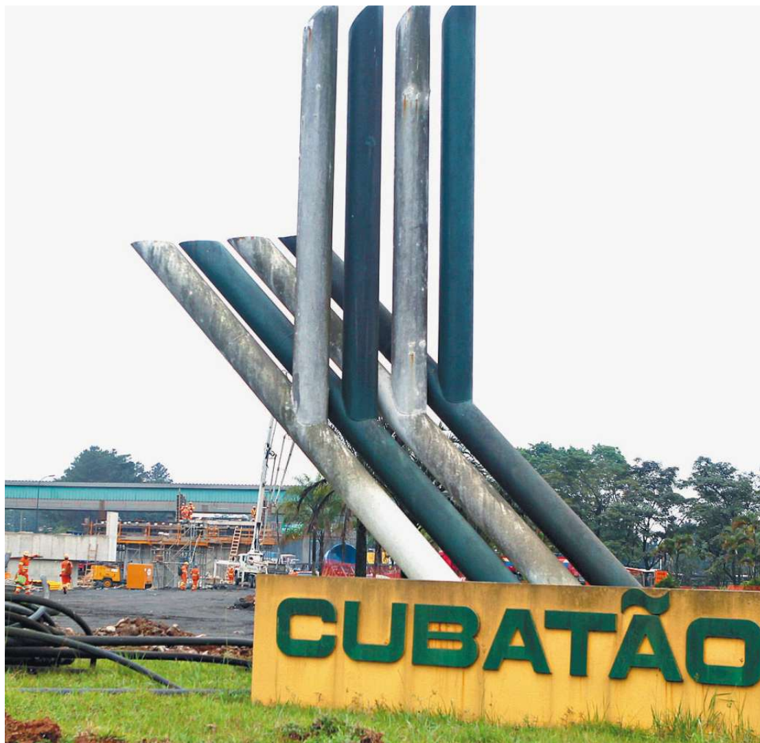
Projeto prevê que futuro anel viário terá três rampas de acesso sobre a região dos jardins de Burle Marx
