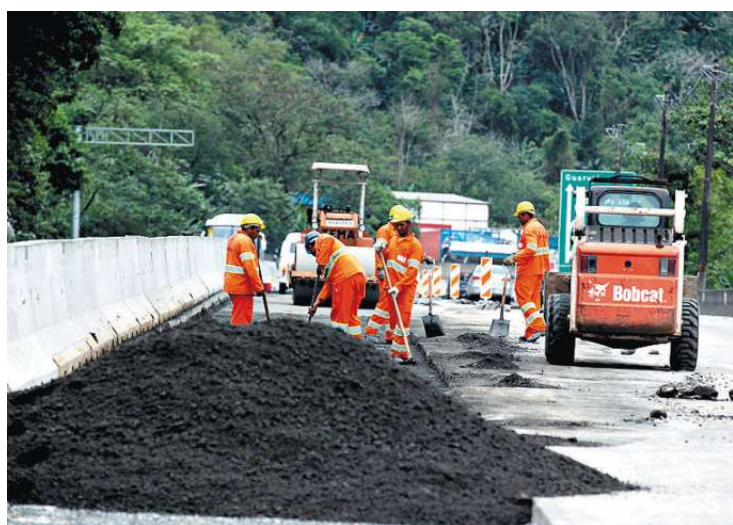
Obras da abertura da terceira faixa na direção sul estão na fase final
