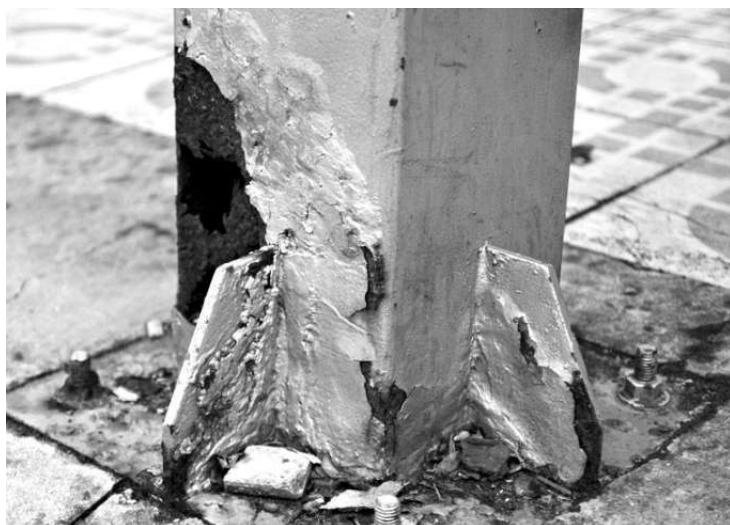
A manutenção das estruturas é responsabilidade do dono do imóvel
