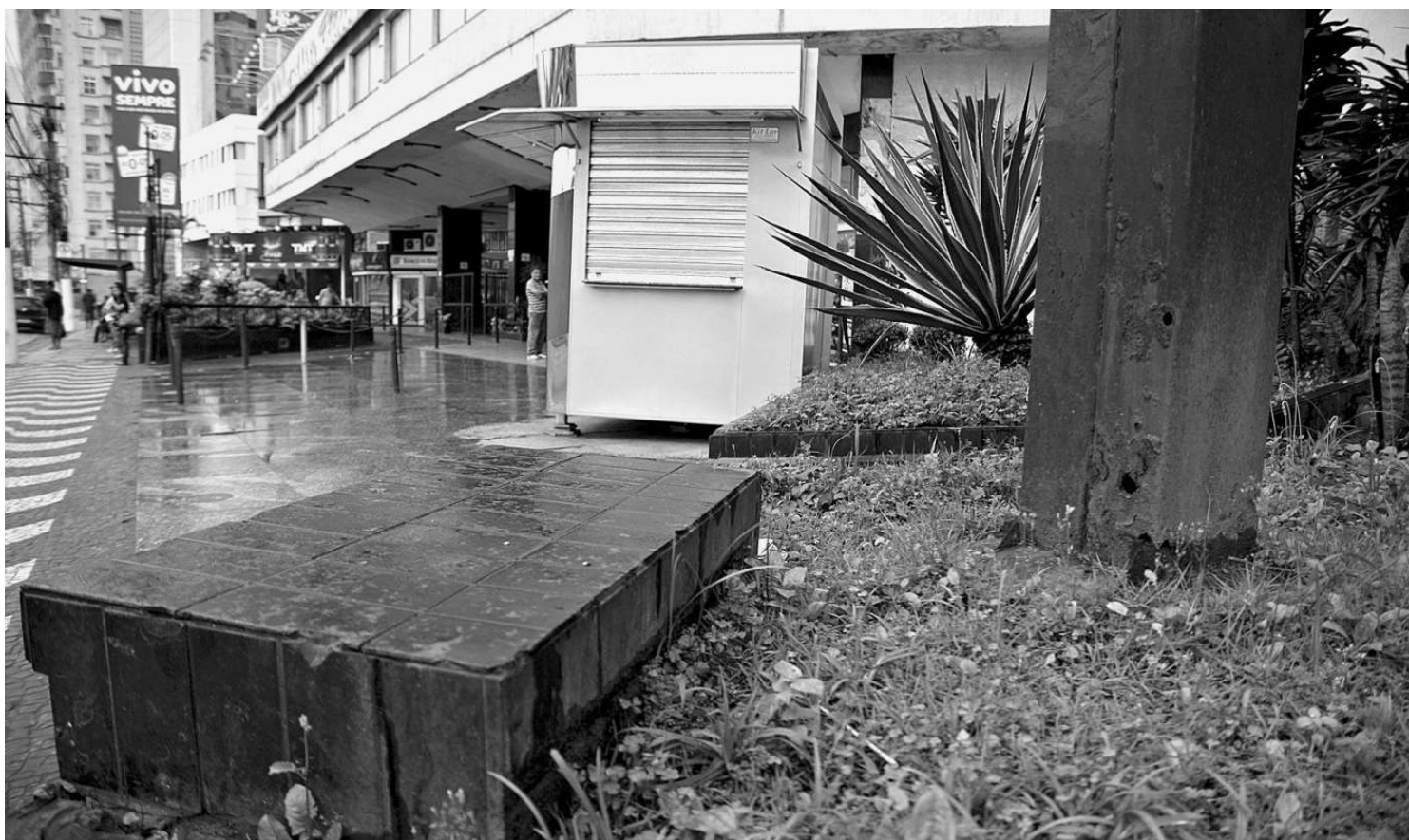
No José Menino, é possível ver a ferrugem na base do letreiro (à direita) de uma casa de shows. Imóvel é vizinho de uma banca e um prédio
