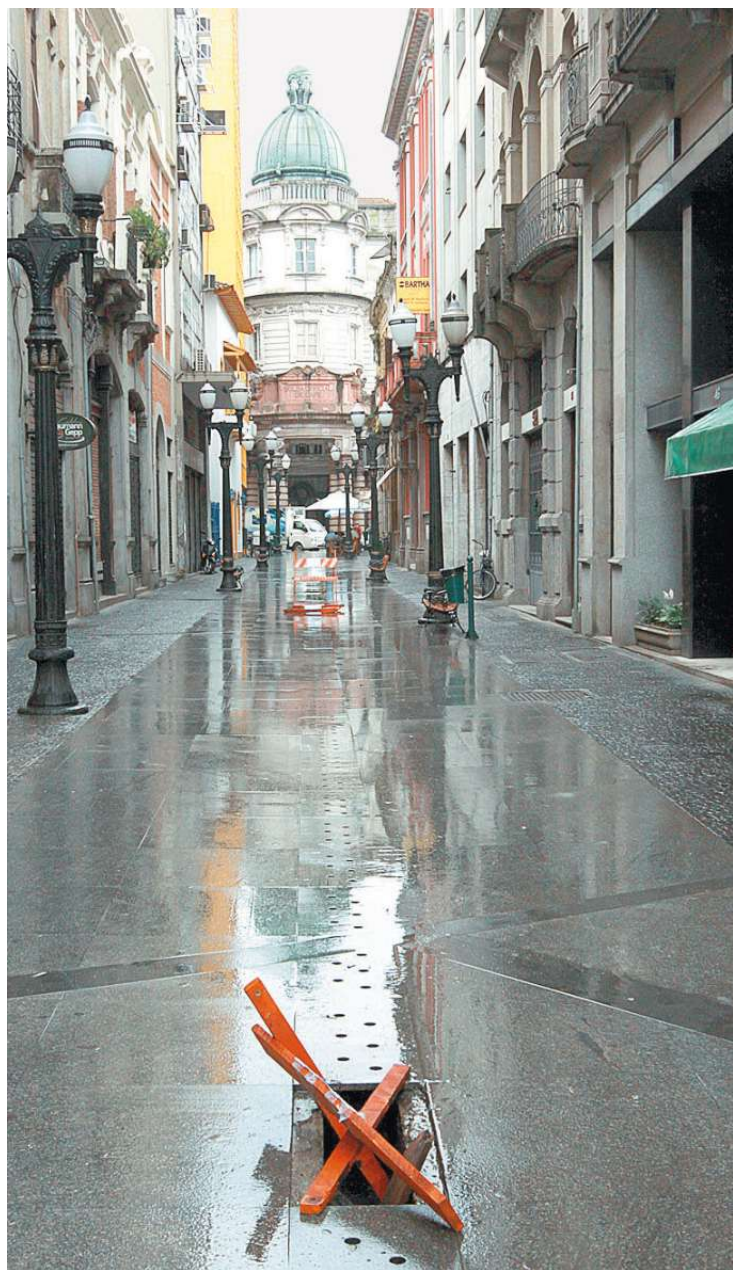
No bulevar, cavaletes improvisados alertam o perigo aos pedestres
