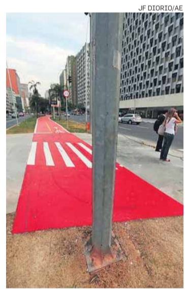
Começo. Faixas no trecho de 2,2 km já foram pintadas
