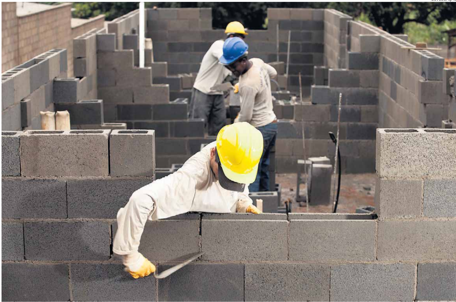
Quebra-cabeça. Alvenaria estrutural, com base em blocos de sustentação, tem aspecto de solidez das obras “clássicas”
