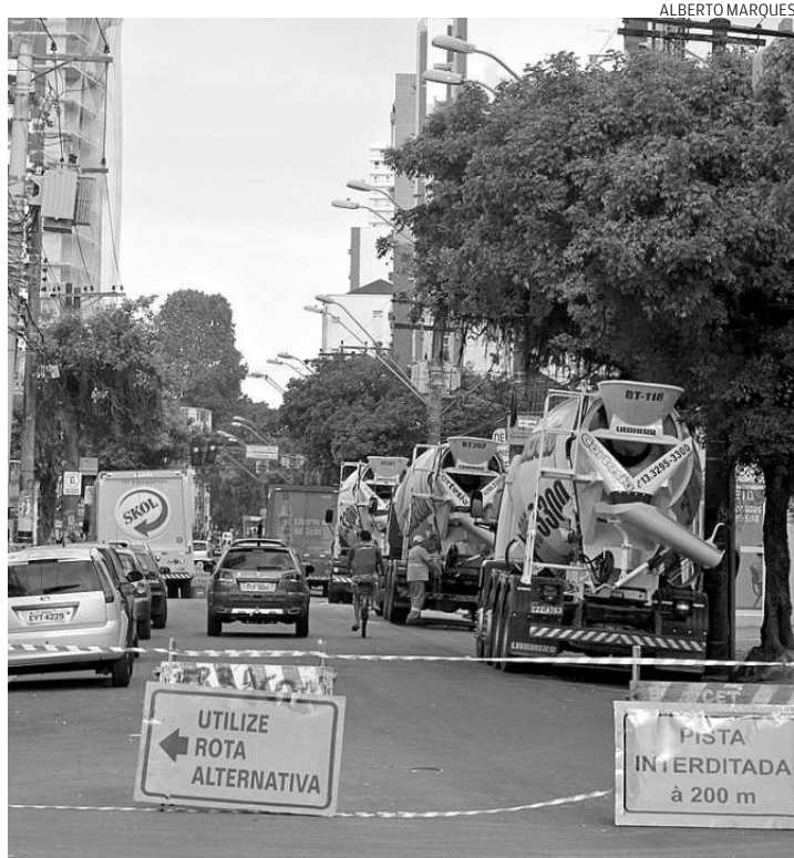
Prefeitura promete para essa semana a conclusão dos trabalhos
