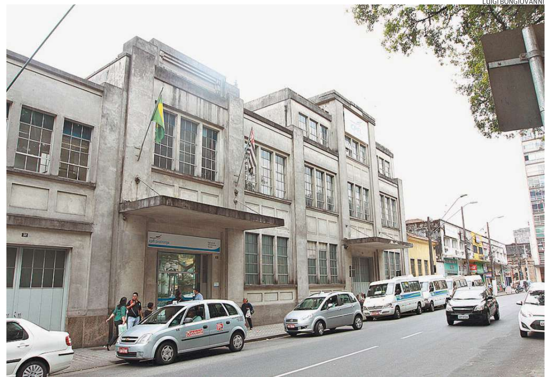
Prédio localizado na Praça dos Andradas, Centro, tem área de 3,5 mil metros quadrados e será leiloado
