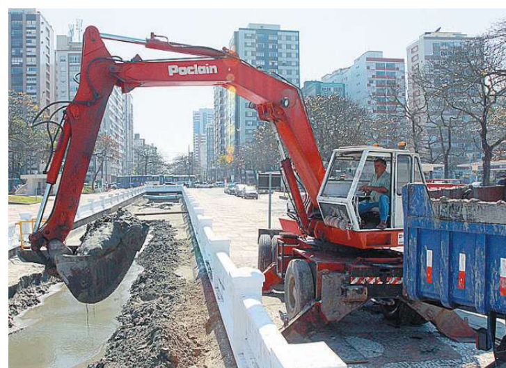
Rotina: a Prefeitura retira o material acumulado com uma escavadeira
