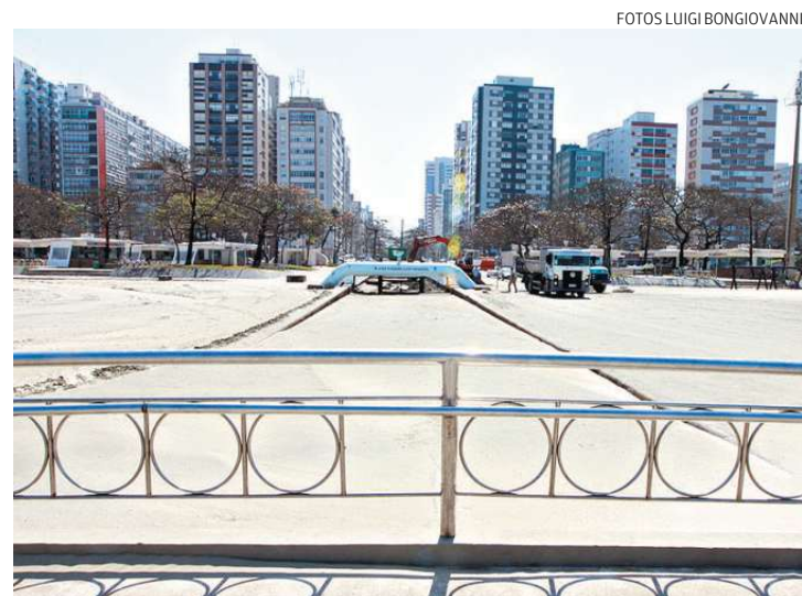
A quantidade de areia é tão grande que chega a encobrir as muretas
