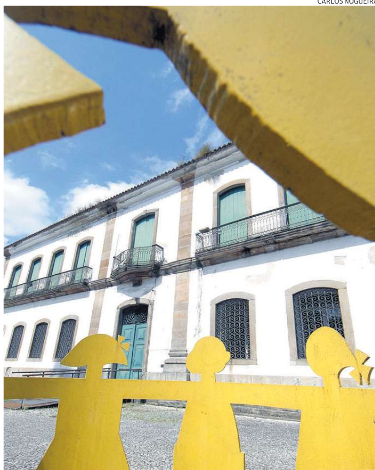
Prédio deve ficar 18 meses em obras para reforma total e restauro
