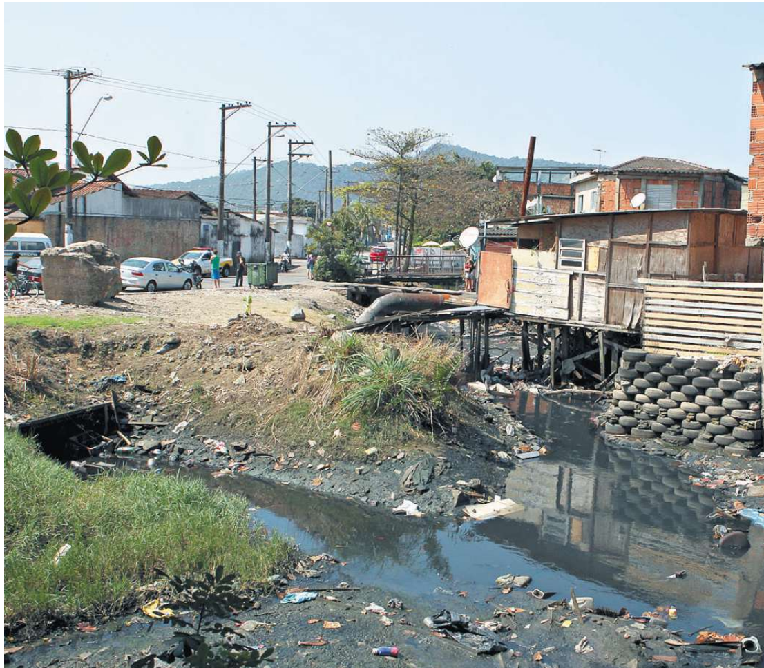
Os trabalhos tiveram início no canal da Rua Haroldo de Camargo, que faz divisa com São Vicente
