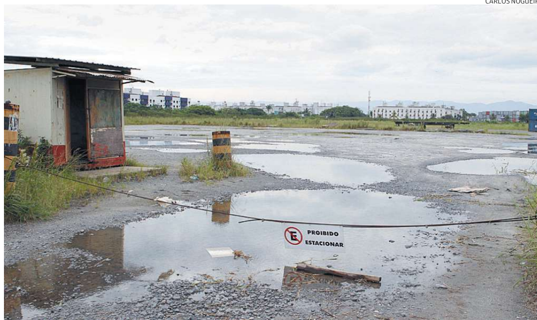
Nova ligação entre a Cônego e a Santos Dumont será construída nos terrenos da Dow e do Grupo Fassina
