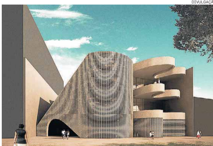
Biblioteca. Prédio em obra integra complexo de R$ 29,3 mi
