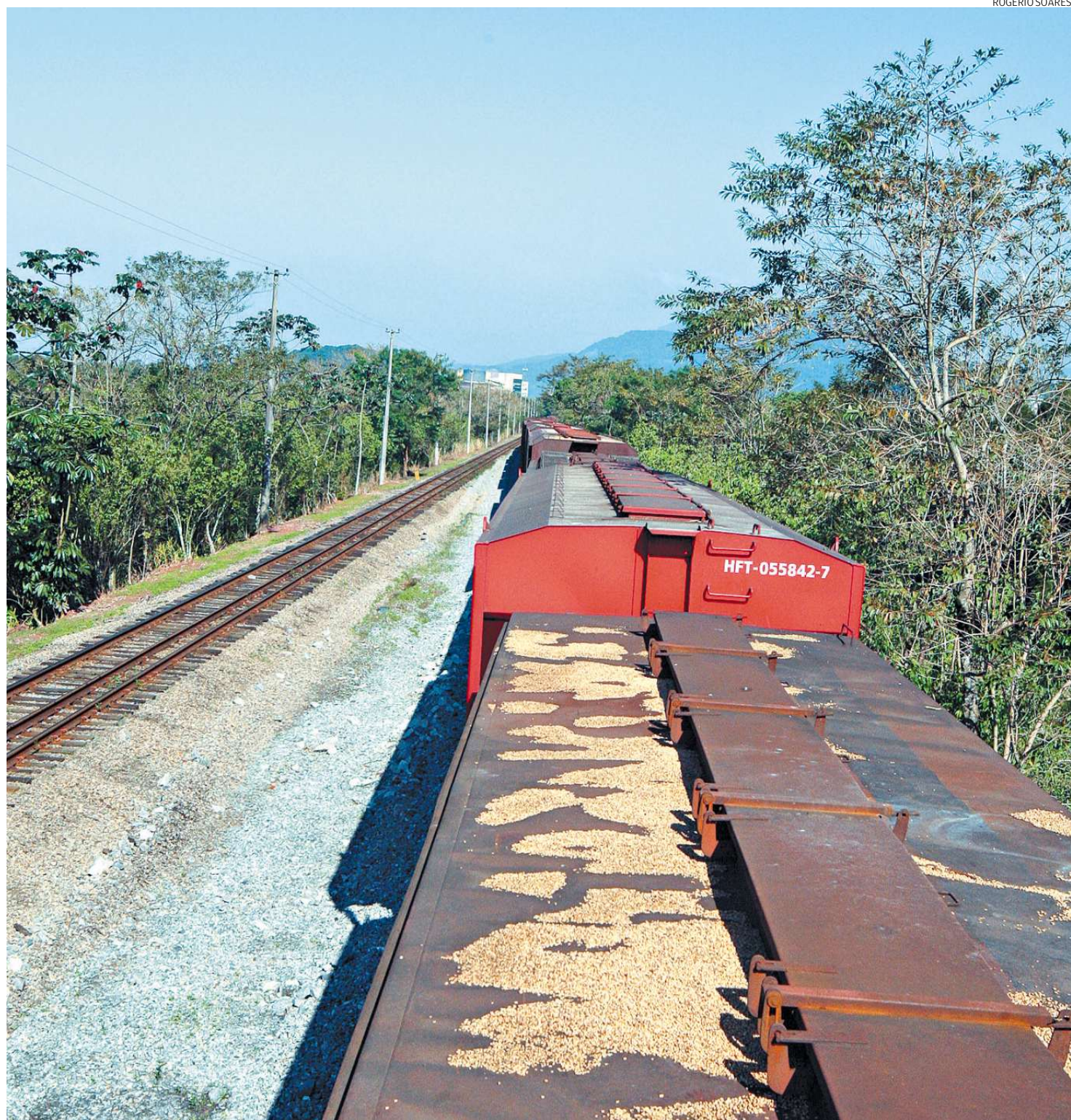
Trajeto proposto para a estrada segue as laterais do leito da atual linha férrea entre Piaçaguera e o Porto de Santos
