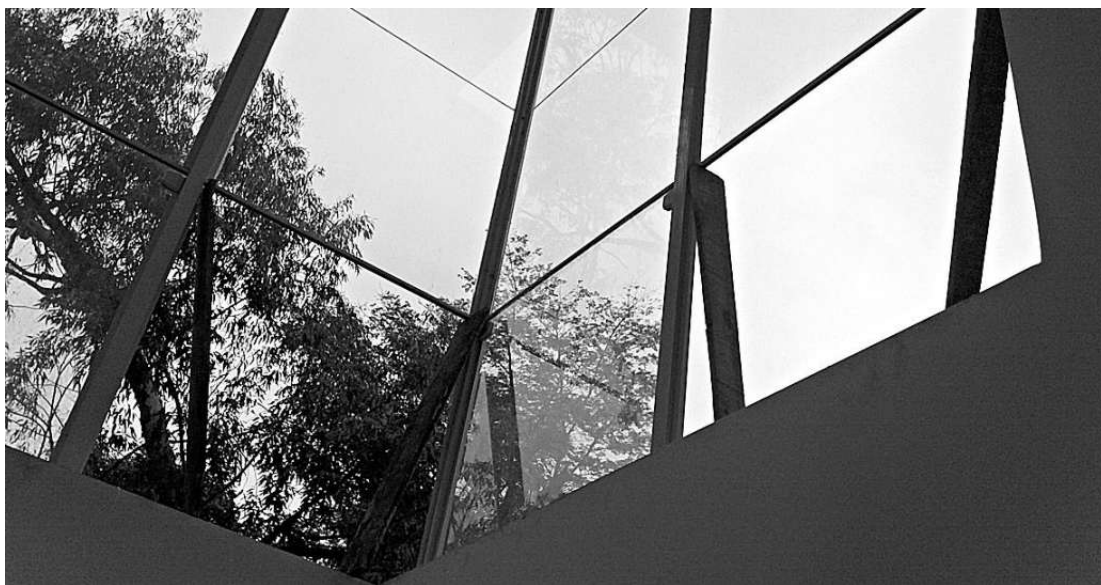
No lugar dos vidros, pedaços de pau dão suporte às estruturas das janelas dos novos prédios do parque
