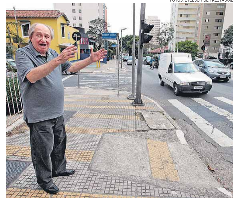
Os erros. Engenheiro Luiz Célio Bottura mostra deficiências dos corredores: falta de pontos de travessia; desrespeito à faixa de pedestre; e rampa para cadeirante em local inadequado
