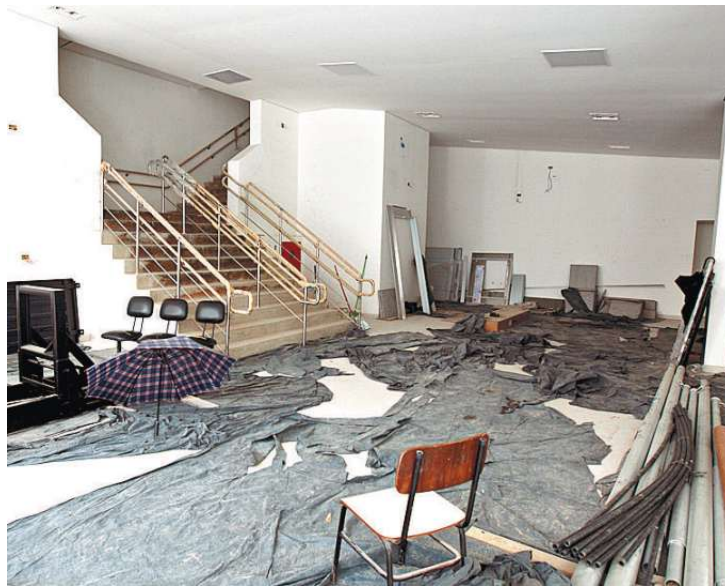
Trabalhos estarão concluídos entre o fim deste ano e o início de 2014
