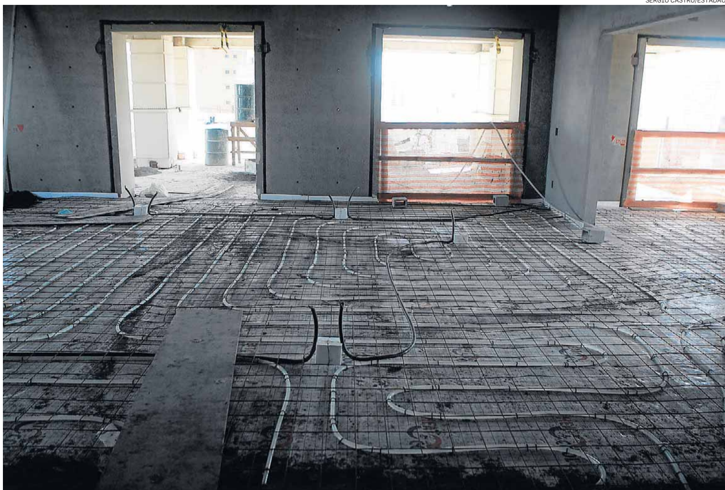
No chão. Aquecimento do piso é método mais eficaz, segundo especialista, mas instalação pede retirada de revestimentos
