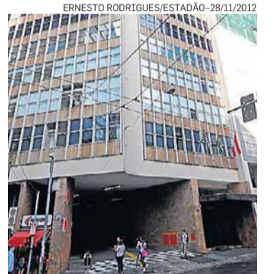
Rua Boa Vista. Prédio foi inaugurado nos anos 1960
