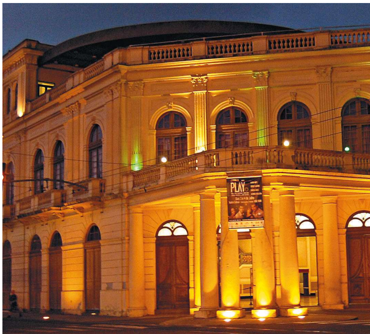
O prazo inicial para o término das obras do teatro era de meros dois anos e meio. O tempo, e o dinheiro, se prolongaram.
