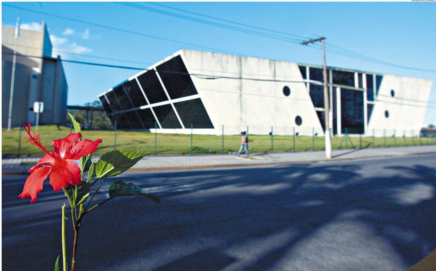
A instalação de monitoramento predial em suas unidades no País, como a nova sede da RPBC em Cubatão, permite acompanhar e otimizar o consumo de energia elétrica
