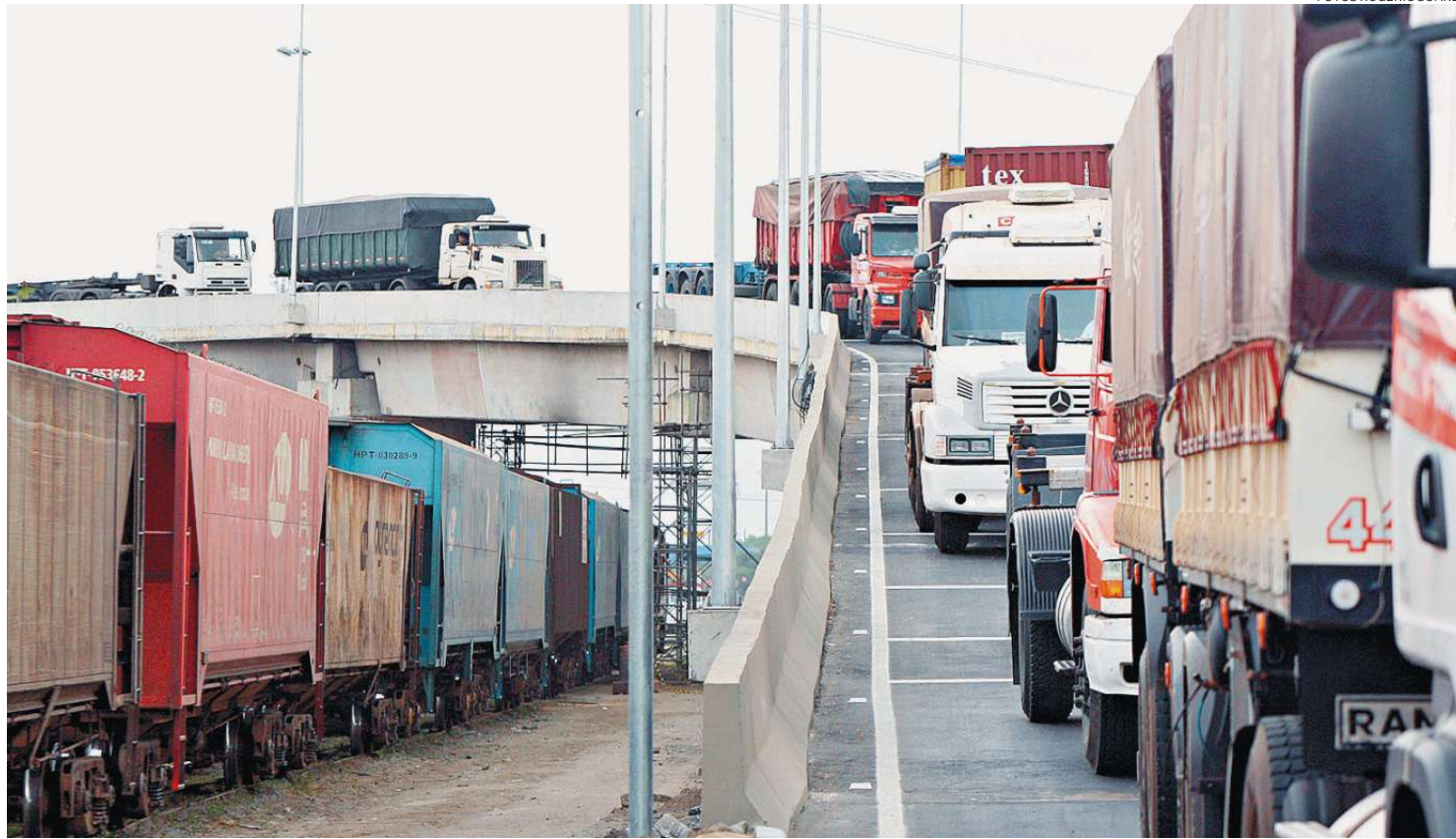
O elevado evita que os caminhões tenham que atravessar a ferrovia e eventualmente fiquem presos por causa dos trens em operação
