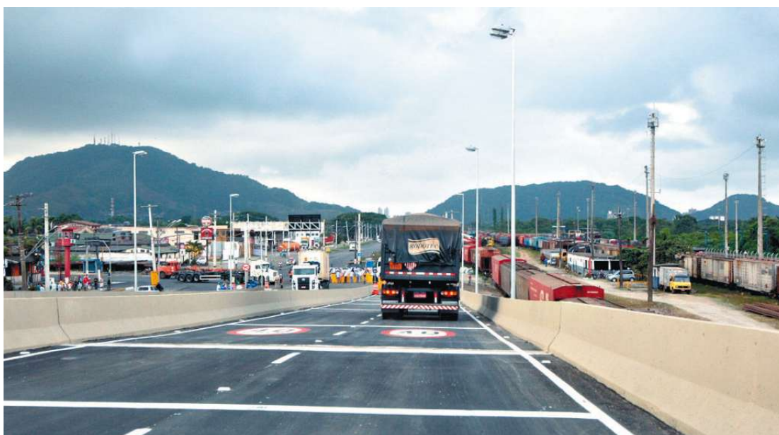
Esta fase da obra prevê ainda o alargamento da Av. Santos Dumont, com cinco pistas no trecho portuário
