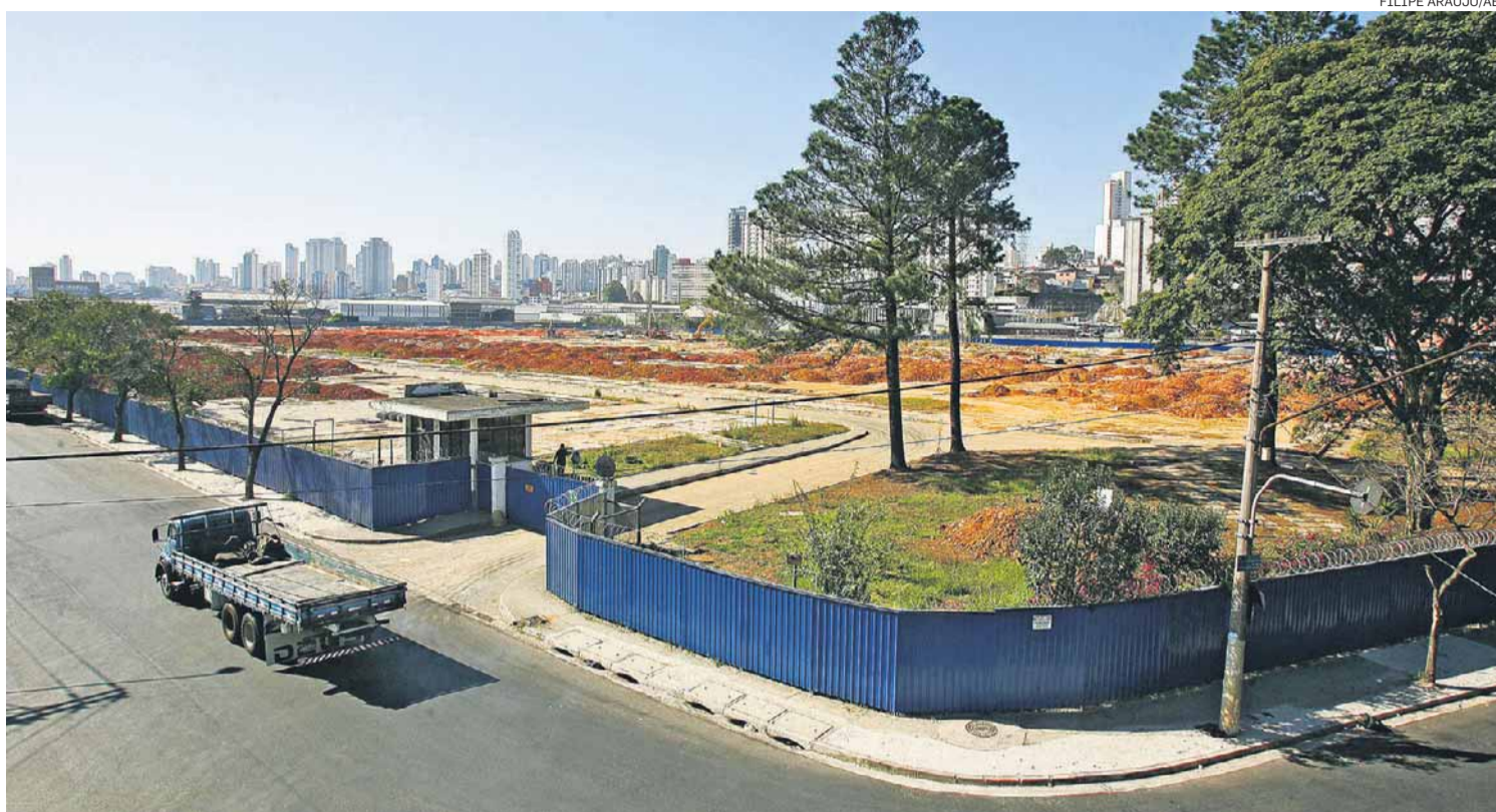
Construção. Atualmente, a área em que será construído o shopping, na Avenida Henry Ford, é cercada de galpões vazios
