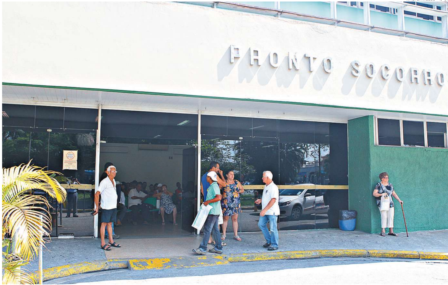
Projetos técnicos dos três prontos-socorros municipais, incluindo o Central, são analisados pelos Bombeiros e aguardam possíveis adaptações
