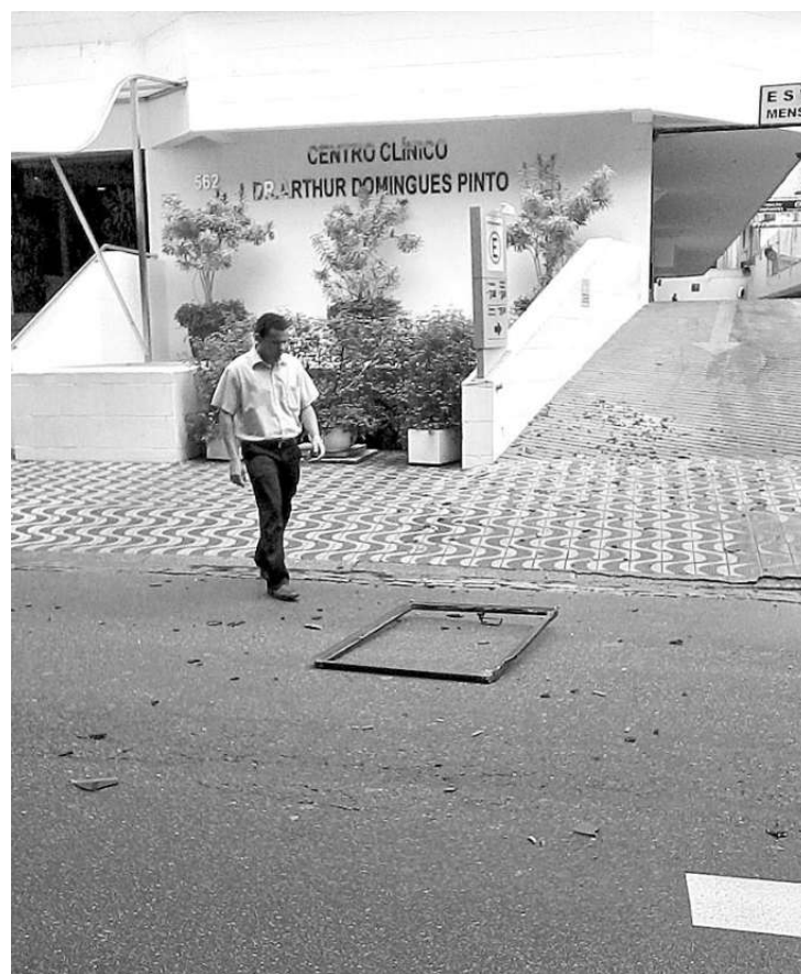
A estrutura caiu na pista Centro-Praia da Bernardino de Campos
