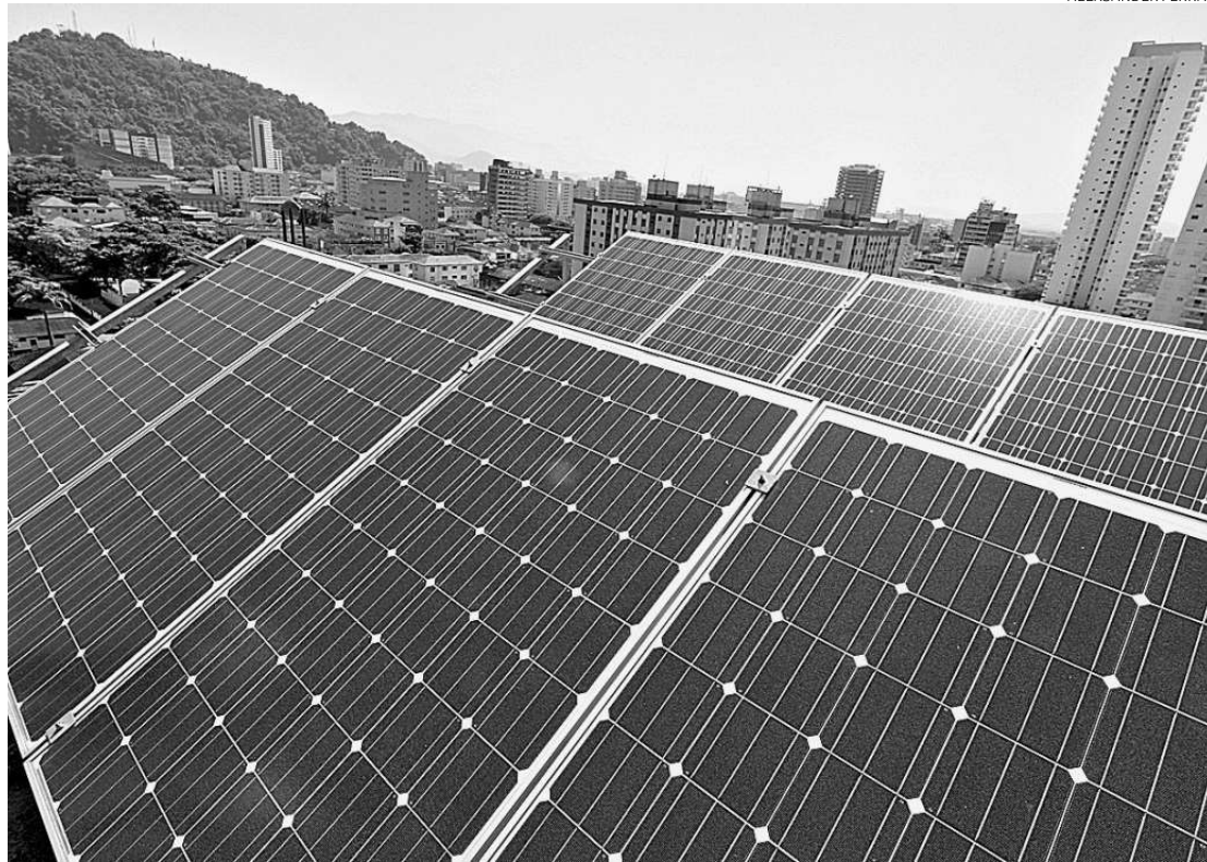
As placas instaladas no alto do prédio do ISO esquentam a água que sai de 22 chuveiros e de todas as pias
