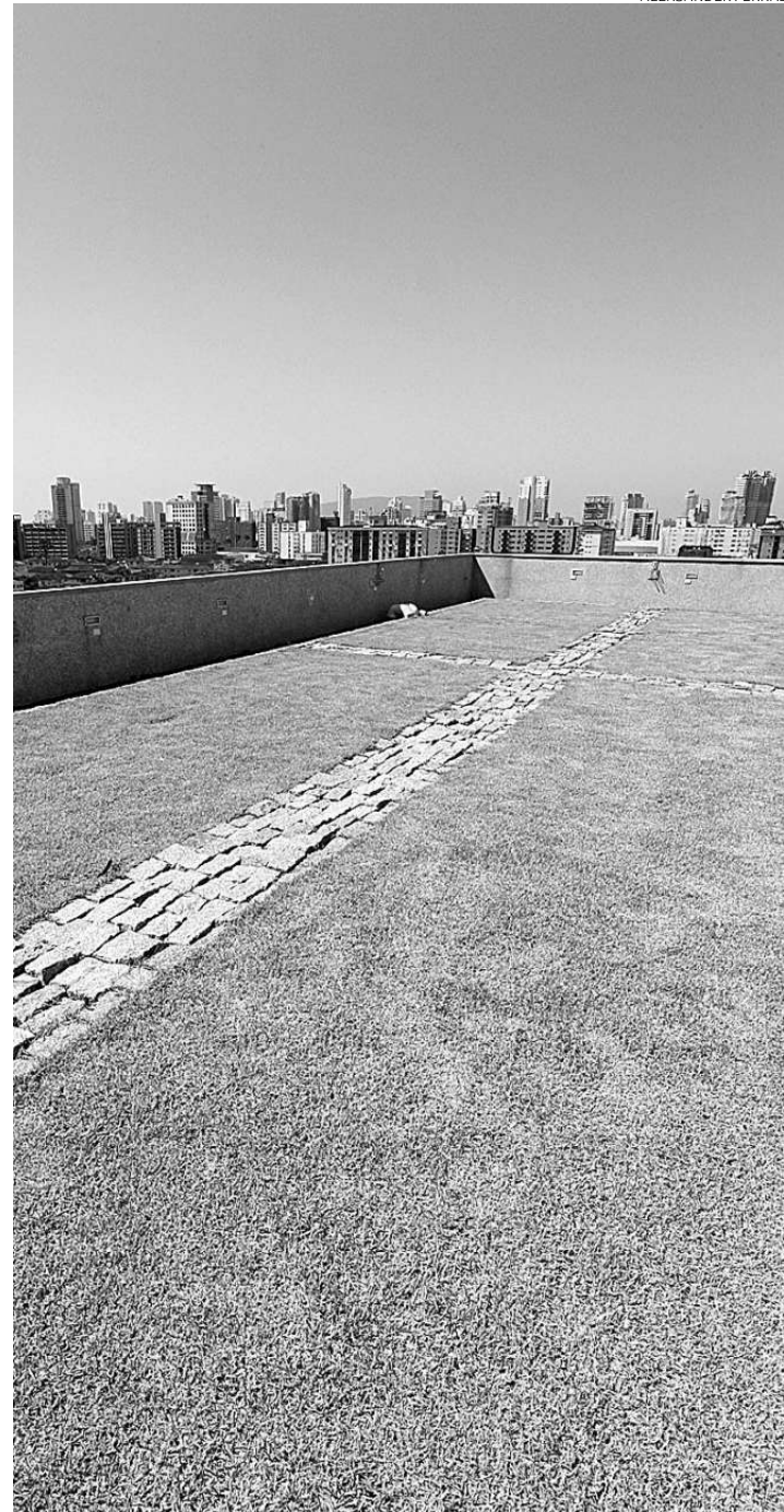
Gramado na cobertura age como isolante térmico e capta a chuva
