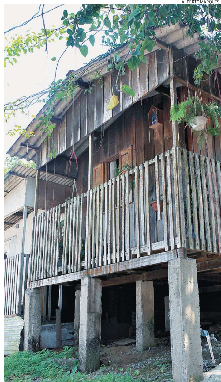
Base de concreto suporta imóvel rústico no Morro da Nova Cintra
