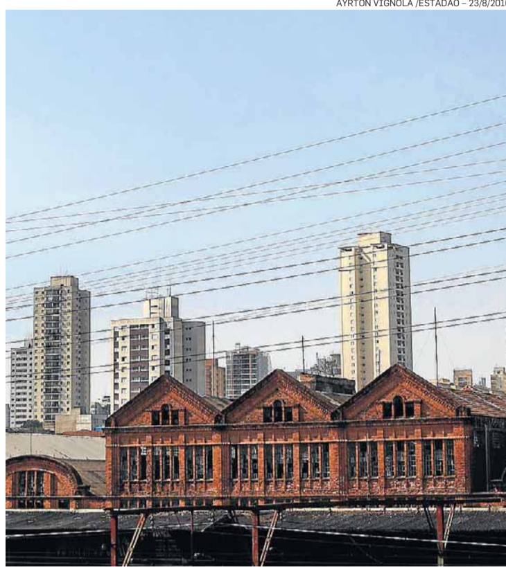
Galpão na Mooca. Seleção de bairros já foi feita pelo governo
