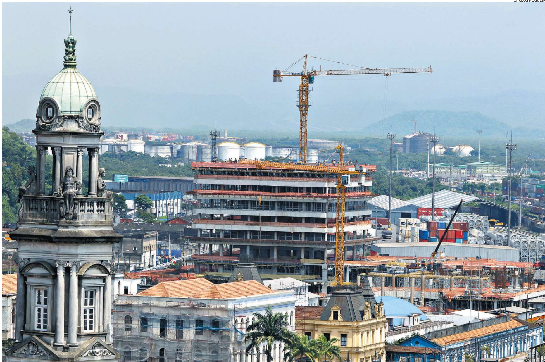
Construção da Petrobras entre edifícios históricos da região central, como a Bolsa do Café (esq.), antiga Câmara e estação de trem: conclusão no primeiro trimestre de 2014
