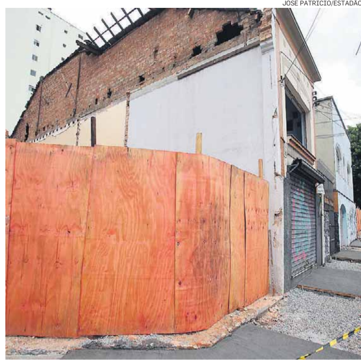
Obra. Imóveis foram demolidos para dar espaço a prédio
