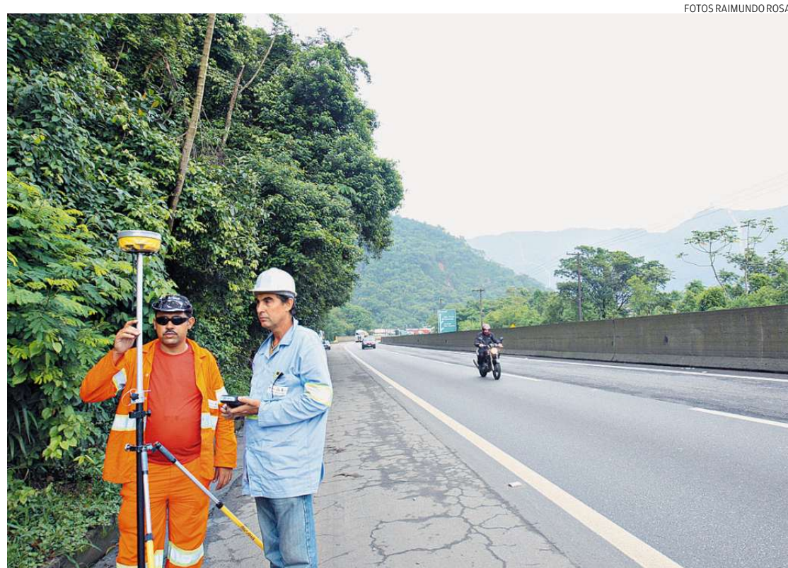
As obras começam pela construção de mais uma faixa de acesso na Rodovia Padre Manoel da Nóbrega
