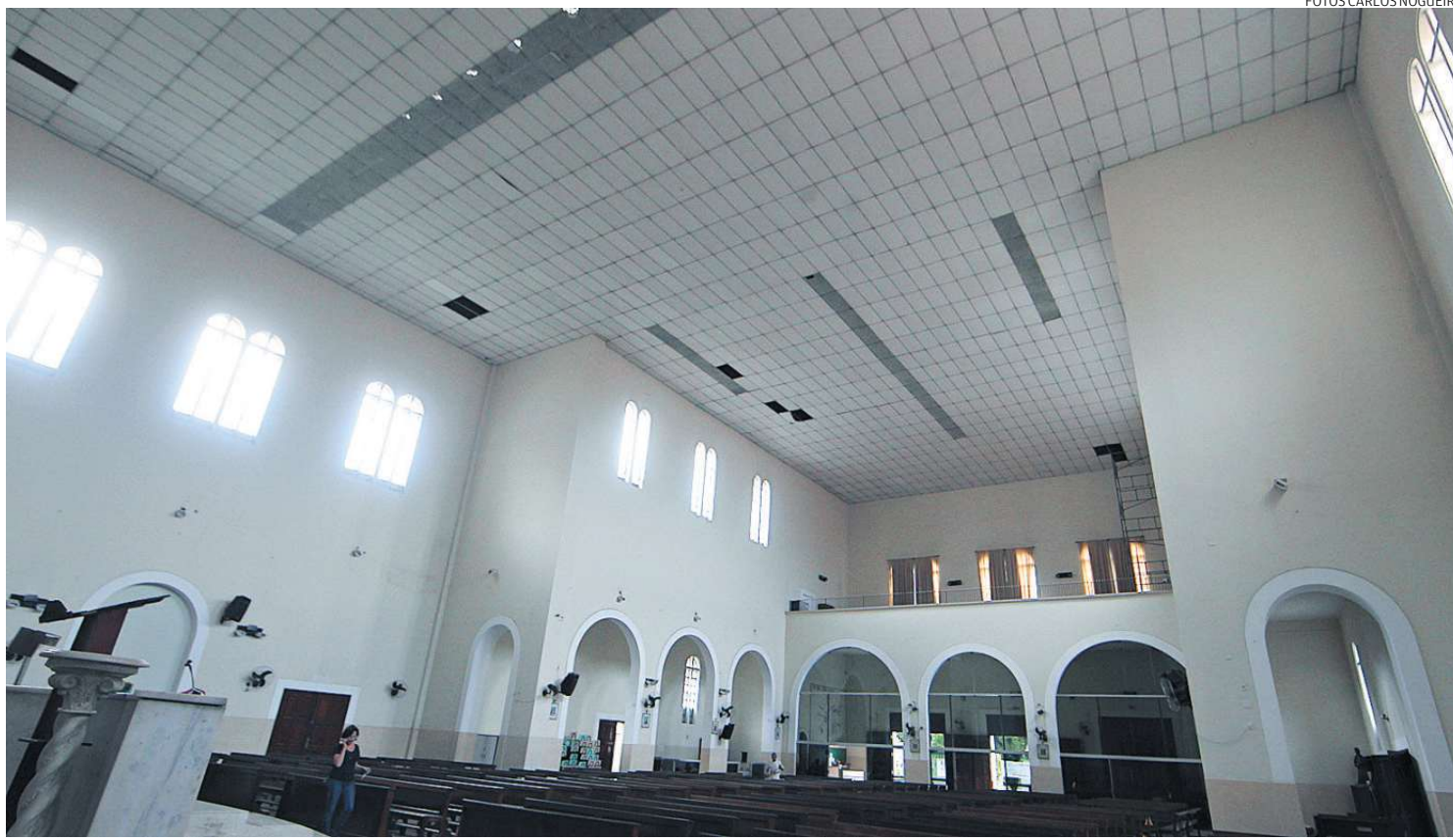
As constantes e antigas infiltrações foram minando o forro da nave: vilã foi a ferrugem nas vigas de sustentação do telhado
