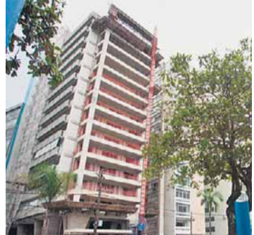
Terraço. Uma nova fachada
