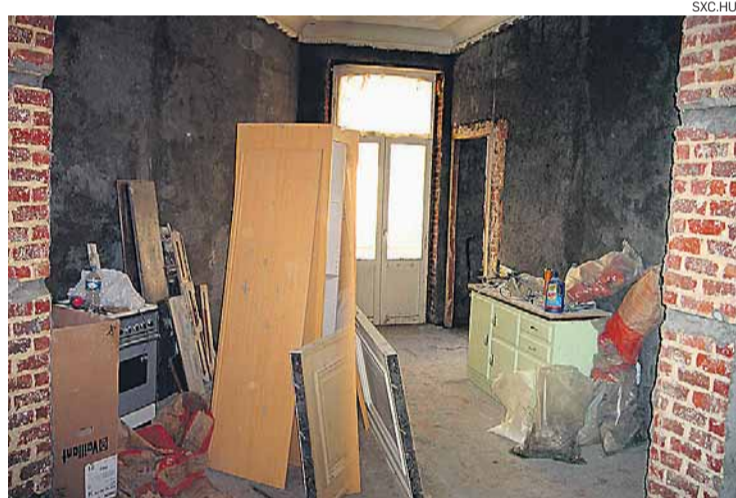
Básico. Antes dos trabalhos, conferir a planta é fundamental
