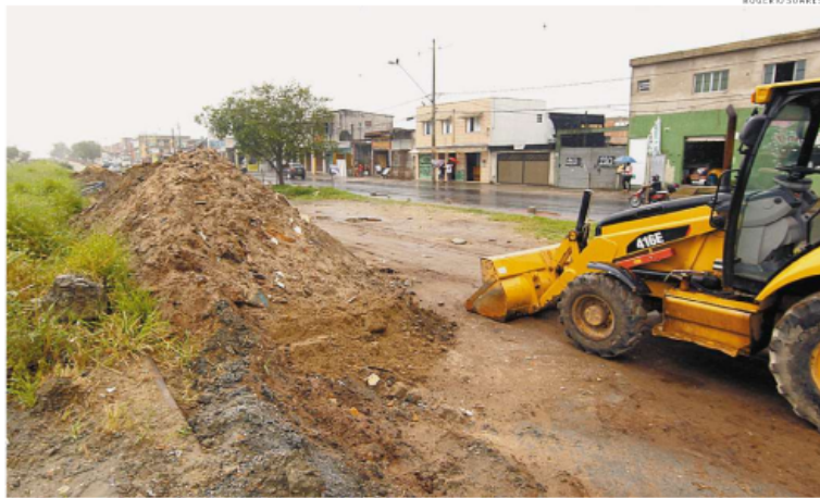
Aos poucos, a empresa responsável vai esvaziando o canteiro de obras, retirando funcionários
