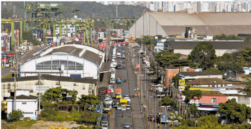
Novo trecho da Avenida Perimetral da Margem Direita será implantado na Avenida Mário Covas, entre a Bacia do Macuco e o Ferry Boat
