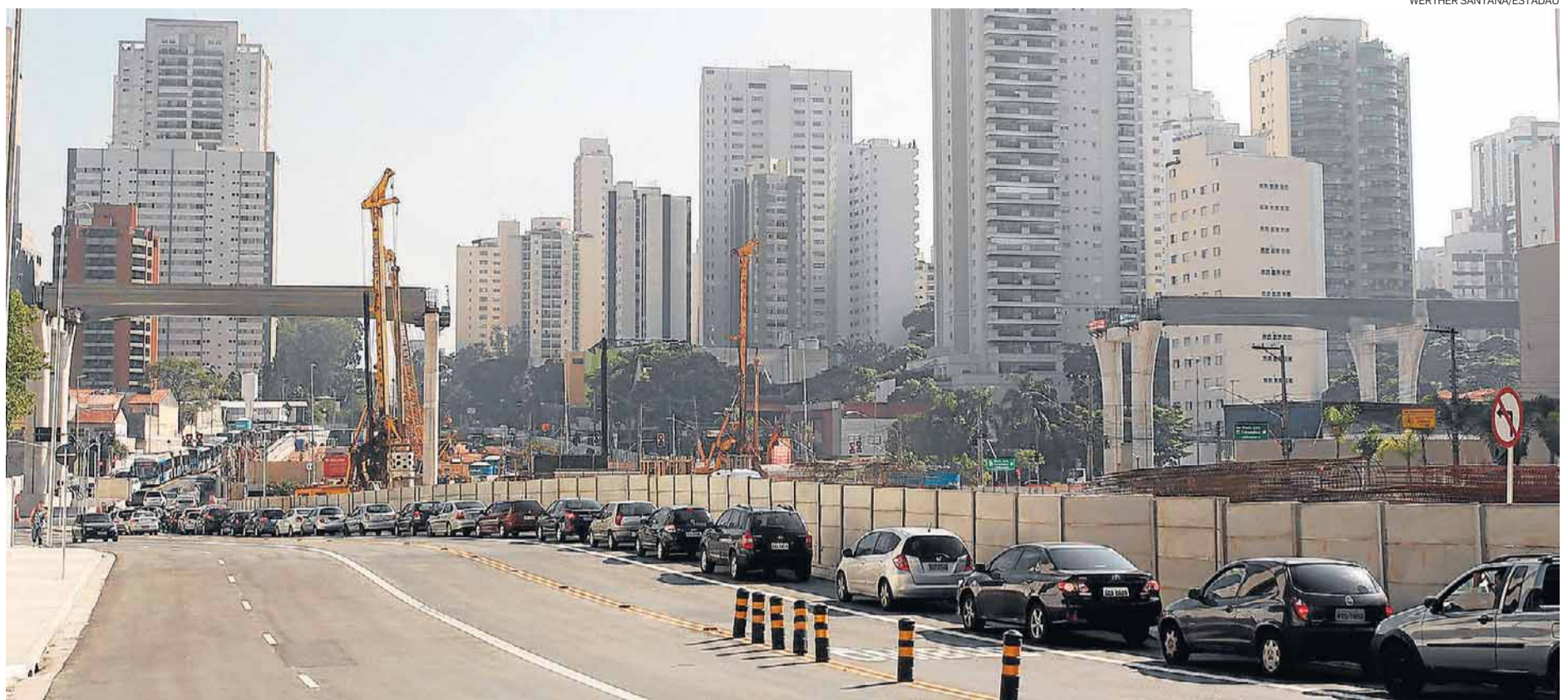
Melhorias. Obras do monotrilho na Avenida Santo Amaro, zona sul da capital, que ganhou novas unidades residenciais e comerciais em toda sua extensão
