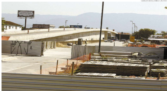
Obra do viaduto da Imigrantes consumiu mais de R$ 35 mi em recursos públicos e não está nem na metade
