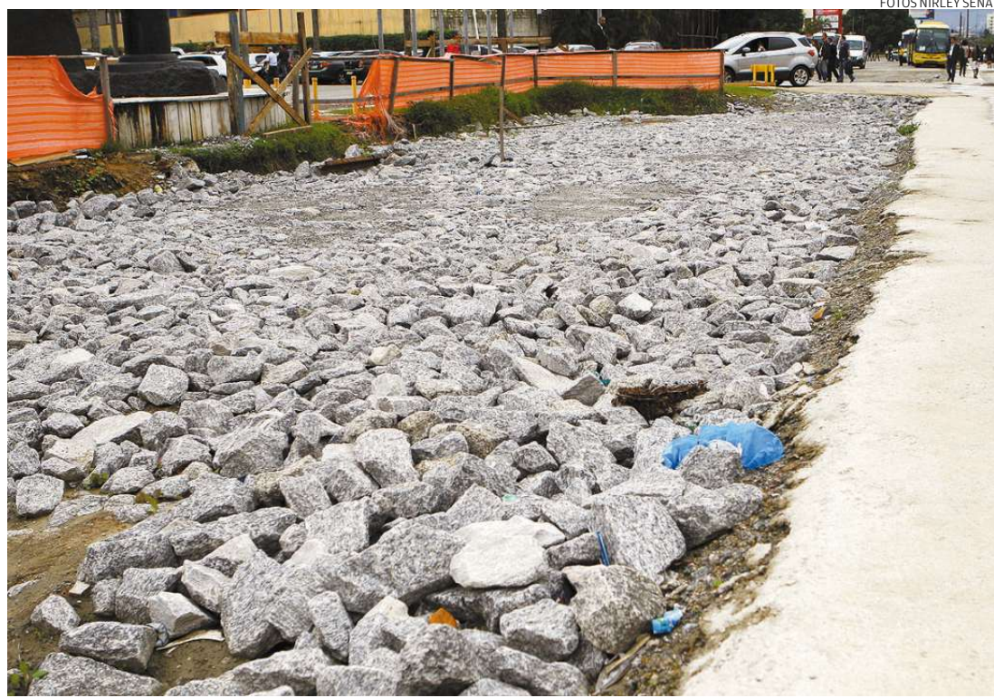
Pedras foram colocadas para pavimentar defronte ao Mendes Convention e da Igreja Evangélica Luterana
