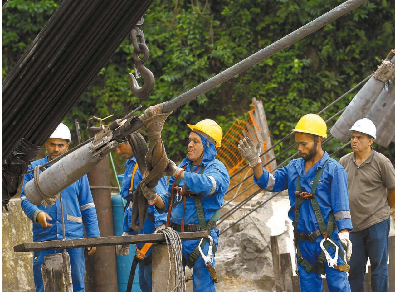
Funcionários da Concrejato, empresa responsável pela obra, atuam na recolocação dos cabos que caíram na 2ª-feira. Esses equipamentos vão sustentar a estrutura da ponte
