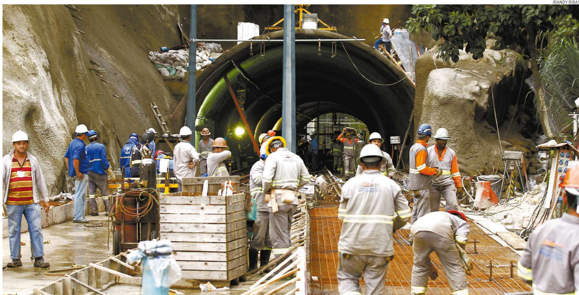
Terminam hoje as obras no túnel do José Menino, para ligação com o lado vicentino da linha do Veículo Leve sobre Trilhos; 280 operários estão trabalhando no local
