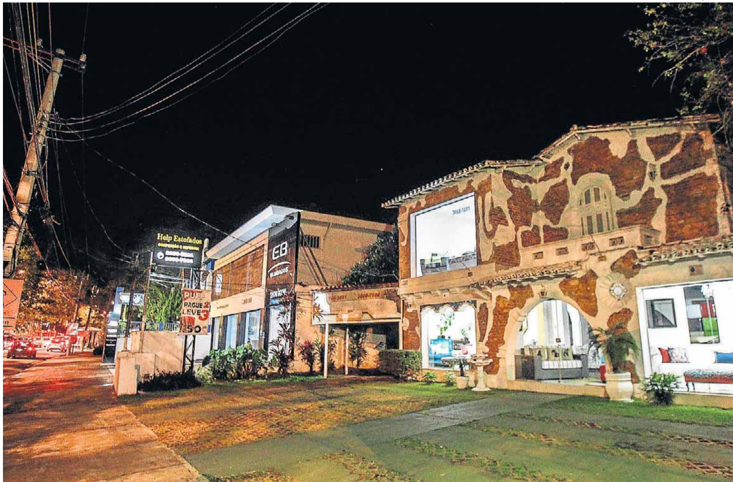
Restrição. Proposta de Haddad mantém proibição de prédios com mais de 10 metros de altura na Avenida Pacaembu
